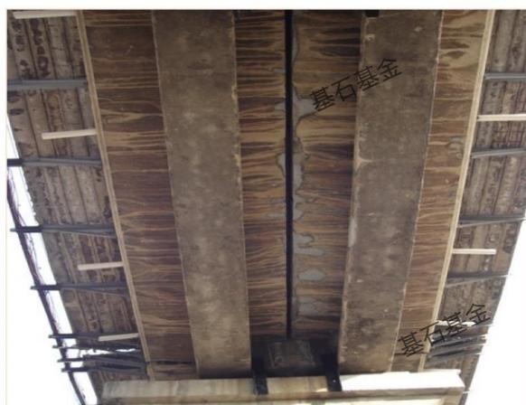
图表 1-19 桥梁支座、主体造成腐蚀
